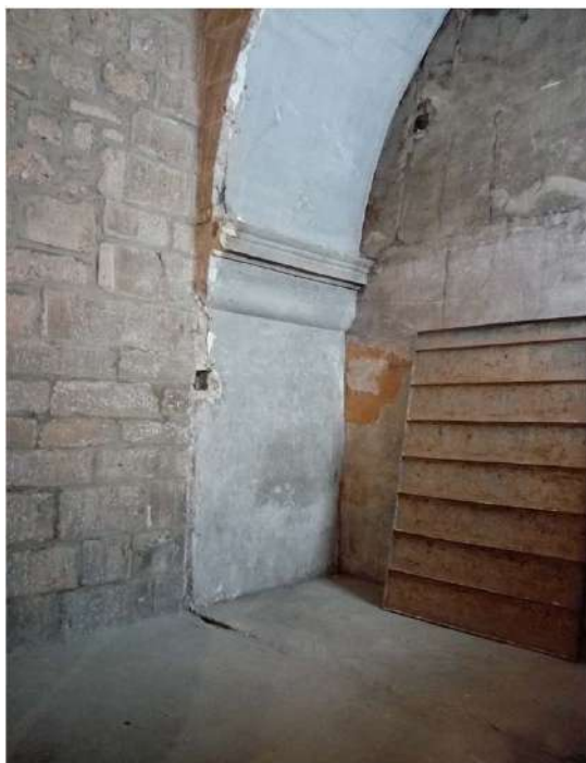
Arco de sillaría descubierto apoyo muro campanario, espesor 1,70 m
