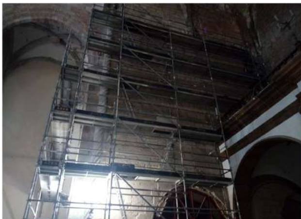
instalacion de andamio para la ejecucion de refuerzo muros torre vieja
