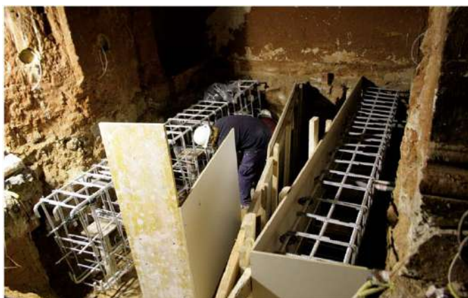
armado de cimentación torre vieja
