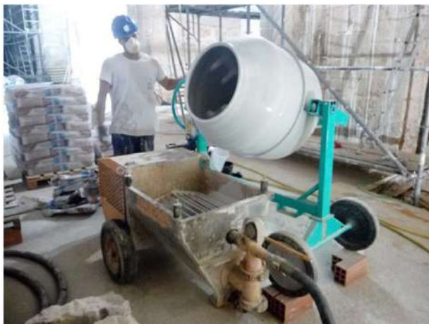
inyecciones de mortero de cal en muros
