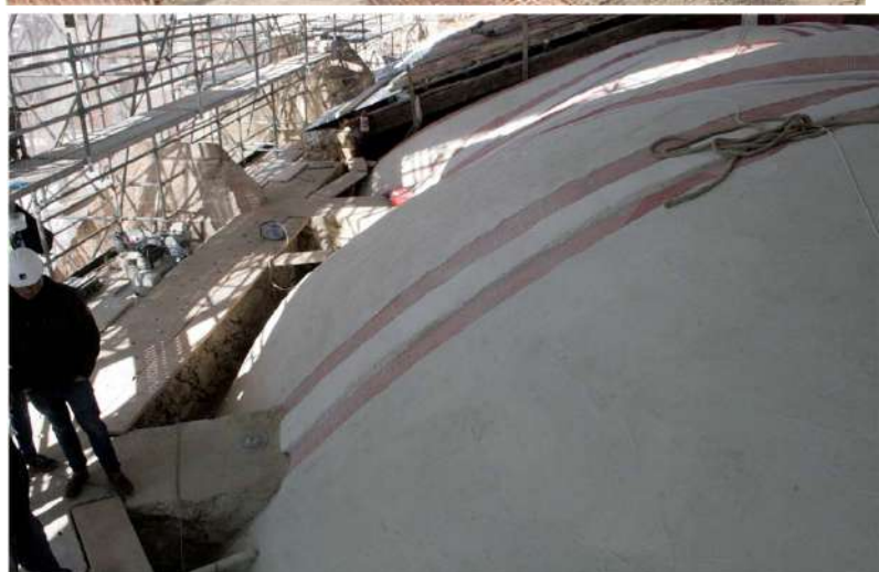
refuerzo de bóveda con mortero de cal y malla de fibra de vidrio
