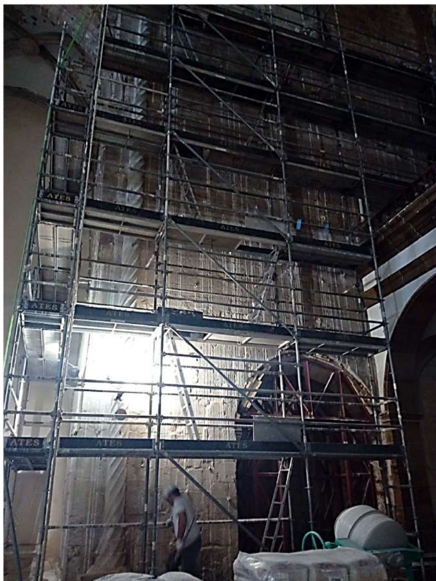
inyecciones de mortero de cal en muros
