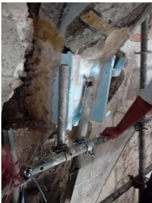
reparaciones en arcos bóveda nave central
