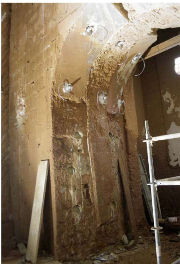
placas anclaje fibras barras de fibras de carbono
