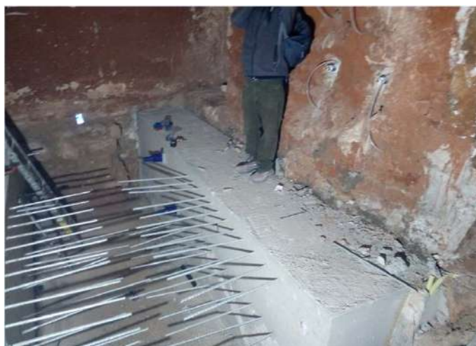
cimentación hormigonada
