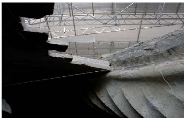
desmontaje tramo de bóveda sobre altar mayor
