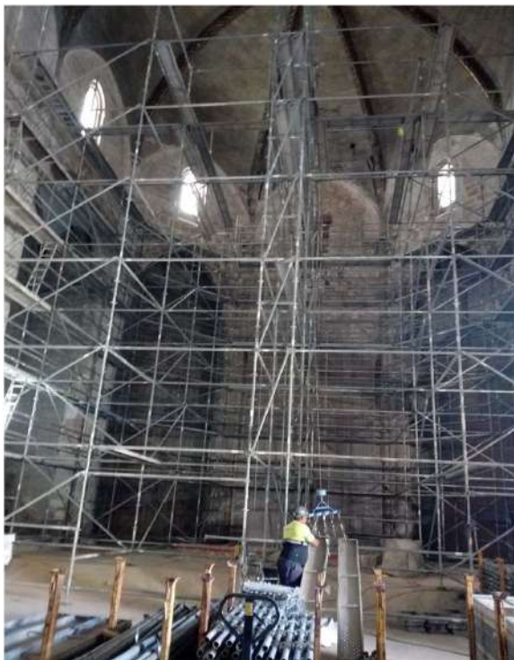
Instalación de andamio interior nave
