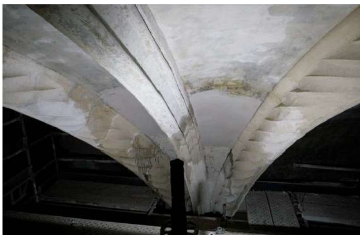
reintegración de dovelas de arcos de bóveda
