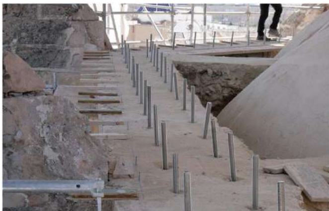
barras anclaje zuncho coronación muro nave central
