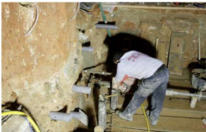
perforación pasante para atado de cimentación
