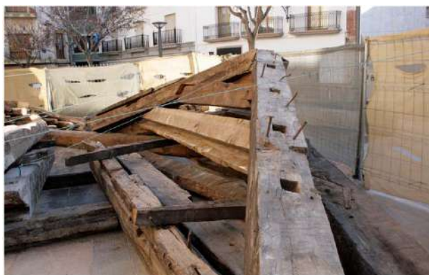
acopio para su conservación vigas de madera de cubierta
