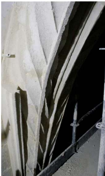
reintegraciones en arranque arcos torsos presbiterio
