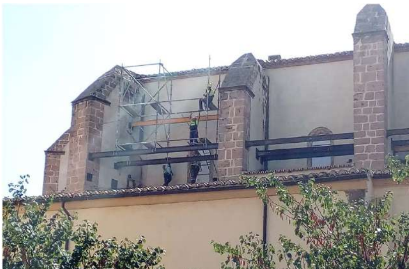
inicio de montaje de andamios exteriores
