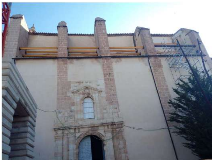
colocacion de placas de anclaje y vigas para apoyo de andamios exteriores y sobrecubierta
