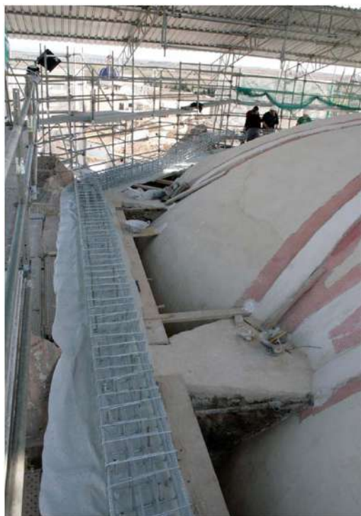
armado y encofrado atado coronacion de muro nave central.
