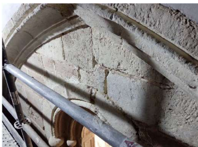
Eliminación de juntas de sillares
