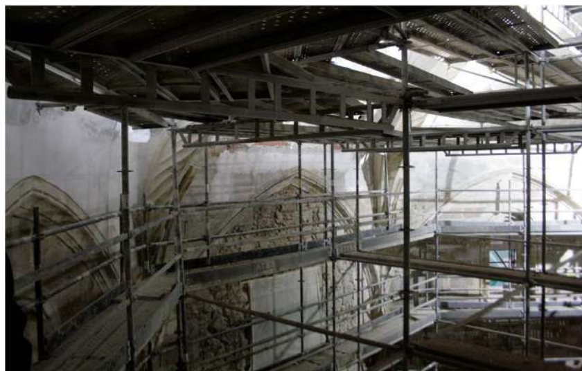
limpieza, reintegraciones en arcos formeros y arranques bóveda plementería
