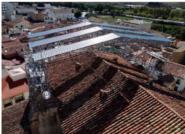
montaje de sobrecubierta
